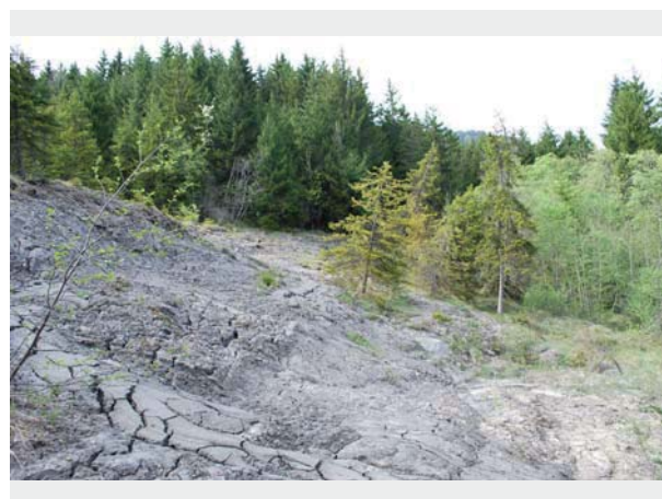
Arbres glissant sur le substrat argileux
