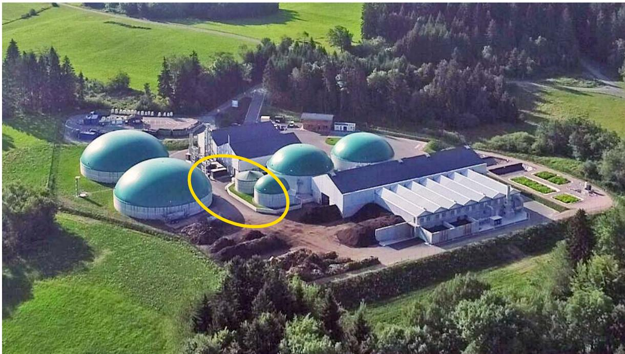
Les CUVE DE PRESTOCKAGE des intrants (plus petites que les autres ; entourées sur la photo) sont situées derrière le hangar : celle avec un toit en forme de dôme accueille les intrants solides, celle avec un toit en forme de chapiteau accueille les intrants liquides.
